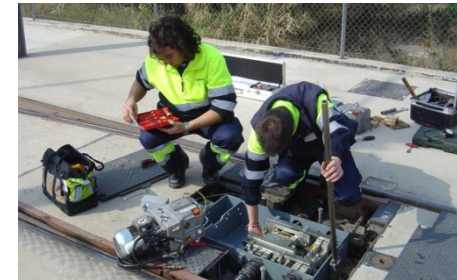
СЦБ, ERTMS level 2
