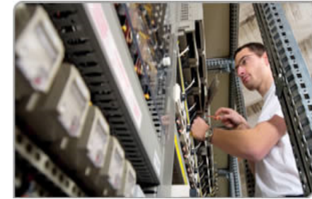
Центр управления ВСМ
