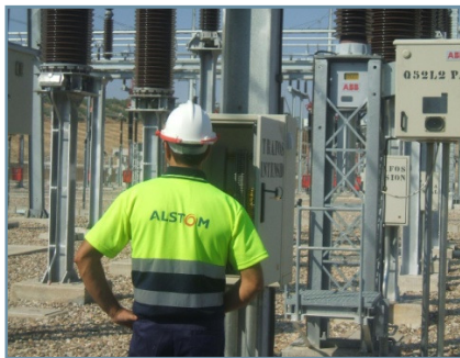
Тяговые и вспомогательные подстанции
